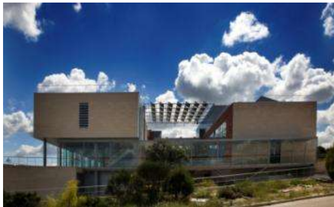
Fig. 31. Vista lateral del edificio del CeDint en el Campus de Montegancedo
