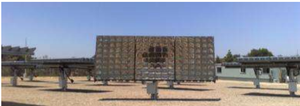
Fig. 29. Vista de un array de forma que el fotógrafo queda dentro del campo angular de los módulos centrales. El resto de los módulos están en operación. al fondo caseta de medidas y mantenimiento
