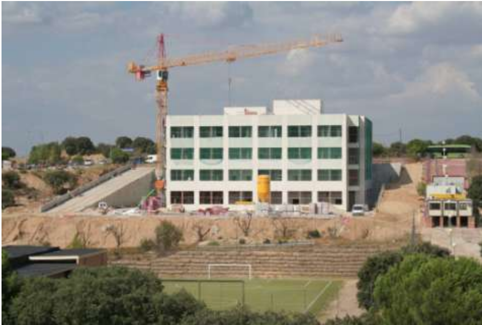
Fig. 22. Edificio CTB. Avance de la construcción Julio 2010.
